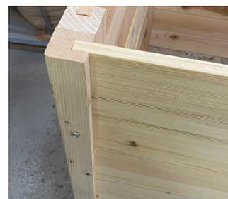
Assemblage des lattes et des poteaux par 2 agrafes de 40mm sur chacune des lattes.
